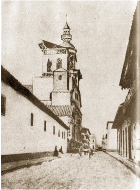
Imagen de la Iglesia de la Compañía desde su costado izquierdo, vista desde calle Compañía hacia el oriente. El muro blanco corresponde al antiguo convento, donde sesionó el Congreso Nacional y donde se construiría después el actual edificio del ex Congreso.
