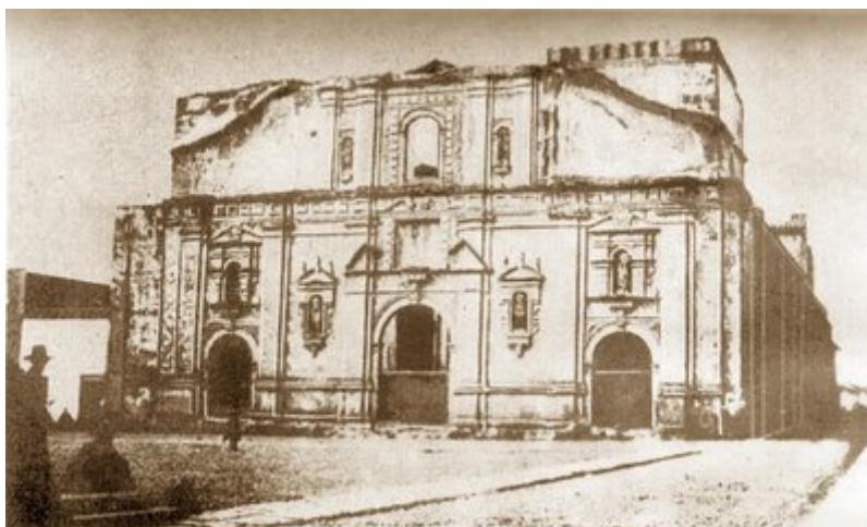
Aspecto exterior de la iglesia después del siniestro. Fotografía publicada por C. Peña Otaegui en "Santiago de siglo en siglo" (1944).
